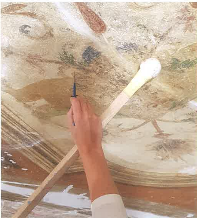
Zagreb, Gornjogradska gimnazija, stropni ostik svečane dvorane tijekom radova (arhiva GZSKP-a, snimka: A. M. Šerić, 2024./2025.) Zagreb, Gornjogradska gimnazija high school, ceiling painting of the ceremonial hall during conservation (GZSKP archive, photo: A. M. Šerić, 2024/2025)
